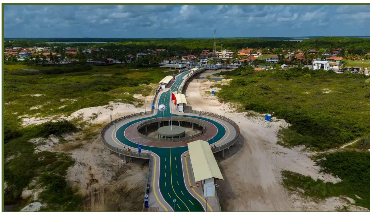
Foto 16: Praia do Maçarico – 2ª Passarela Urbana
