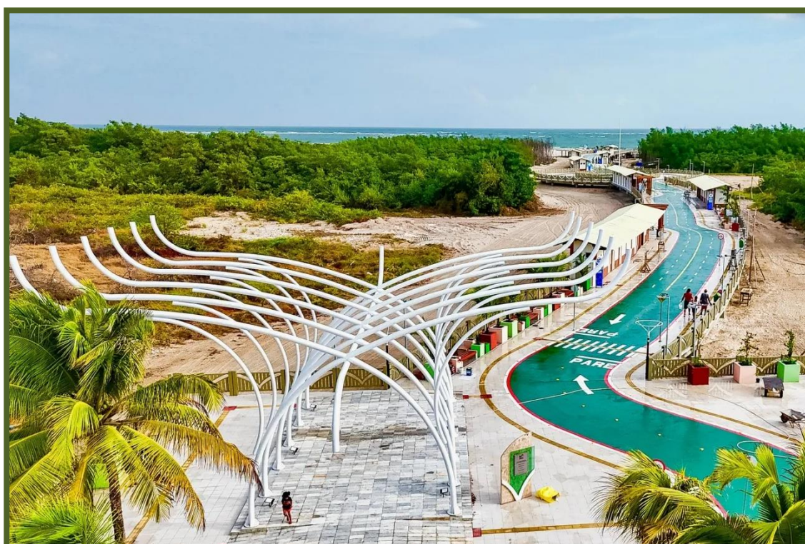
Foto 04: Praia do Maçarico – 1ª Passarela Urbana
