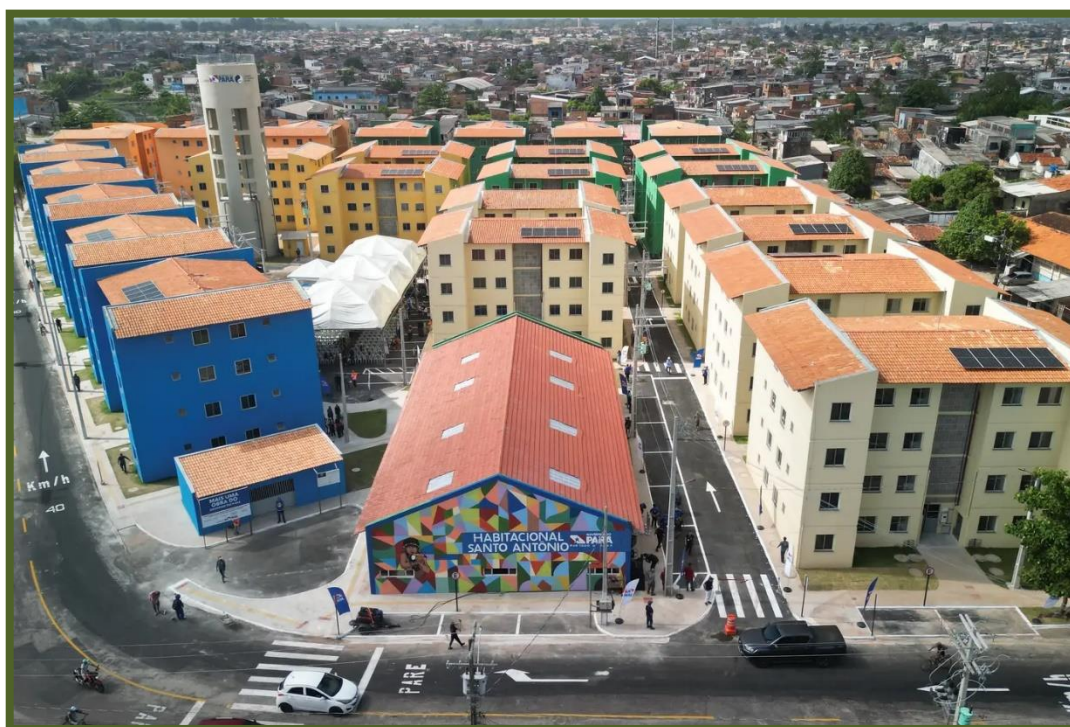
Foto 13: Conjunto Habitacional Santo Antônio
